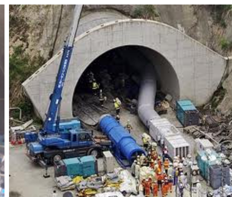
八箇峠トンネル工事現場で噴出したメタンガス爆発事故(2012年5月)
