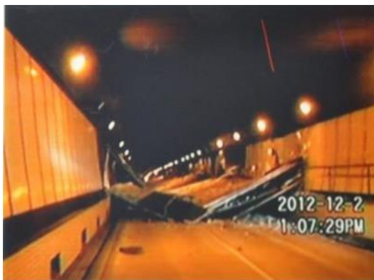
中央自動車道笹子トンネルでの天井板落下事故(2012年12月)
