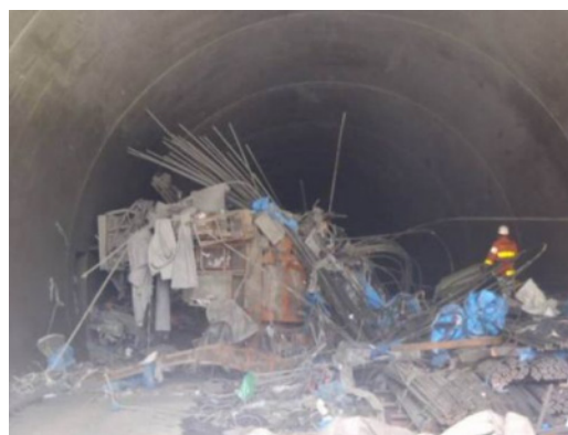
八箇峠トンネル工事現場で噴出したメタンガス爆発事故(2012年5月)
